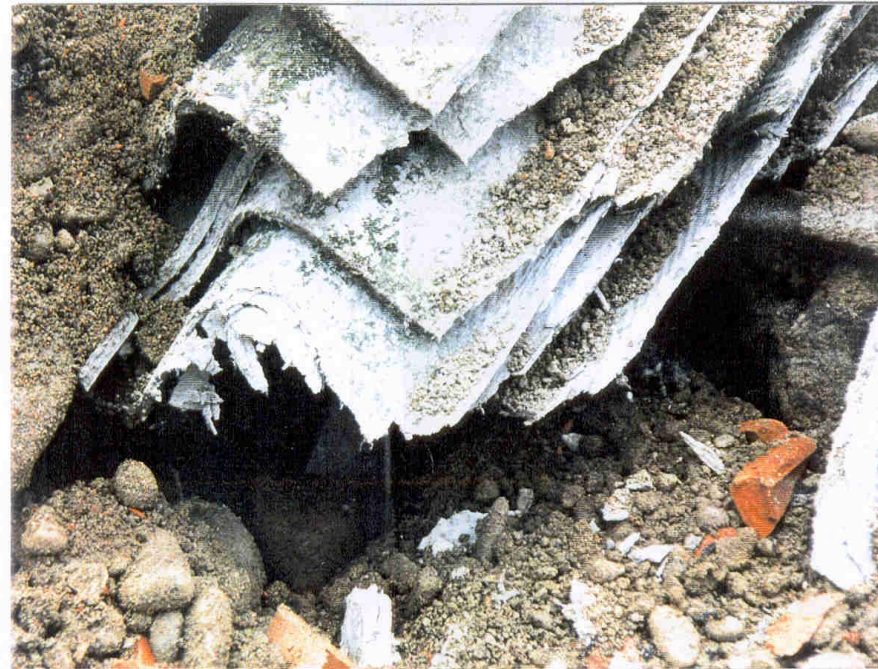
Fotografia n. 16 - Particolare di cemento Amianto smontato
